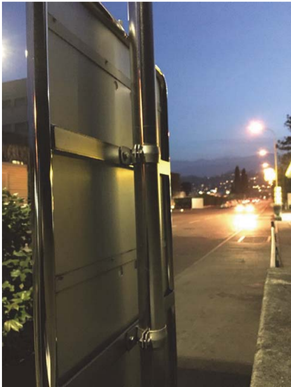
Esempio di ancoraggio della bacheca al palo
